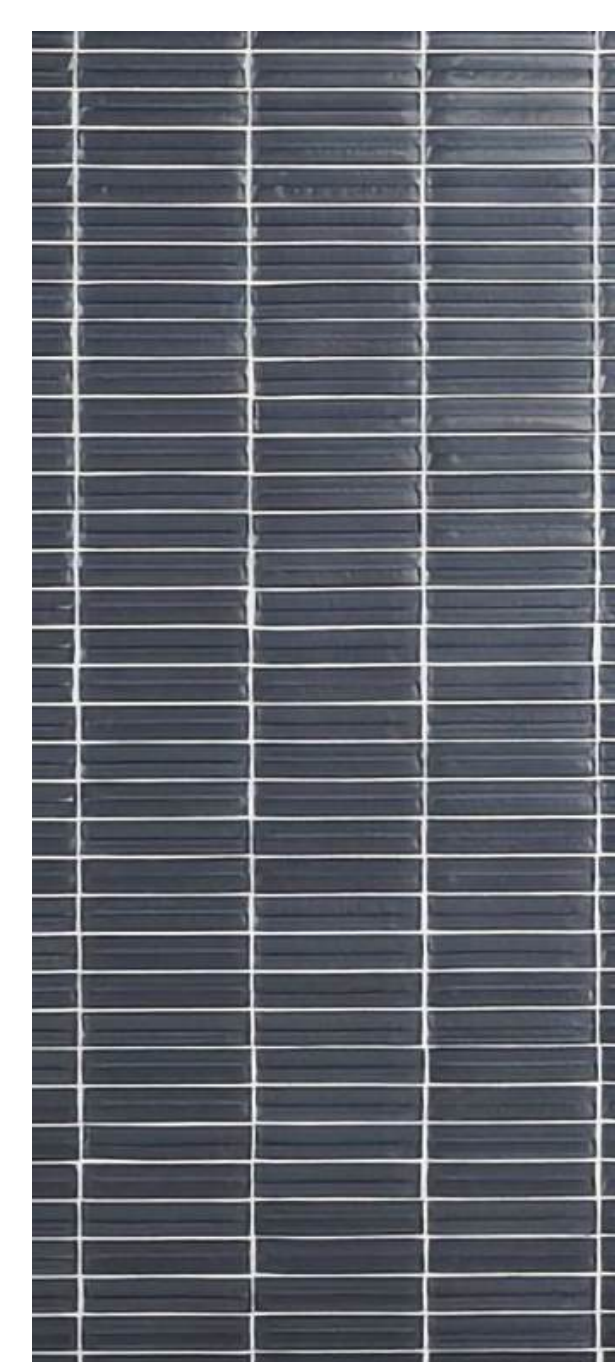
Borstwering begane grond met bakstenen in raster verband
