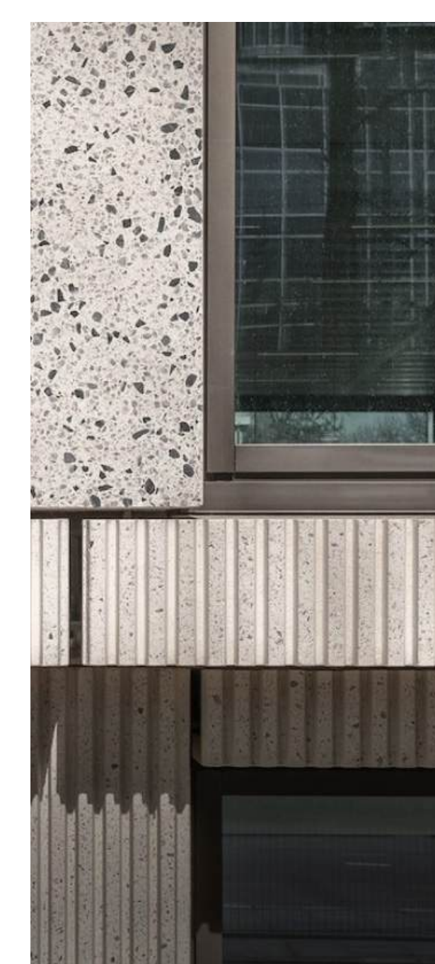
Verticale groeven in beton t.p.v. plint en kroon – kozijnen in warme tint
